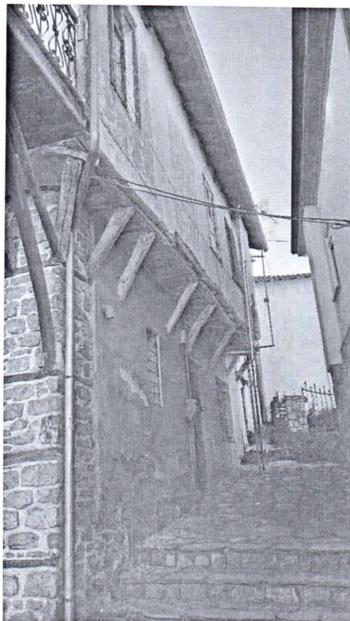
Φωτ 7 Λεπτομέρεια όψης επί της παρόδου (διακρίνονται τα μέτρα αντιστήριξης της καπνοδόχου)
