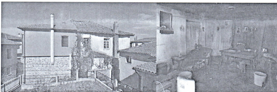
Φωτ 5-6 Αριστερά Όψη Γ, όπου διακρίνεται η ενιαία στέγη με το διπλανό κτίσμα Δεξιά: Λεπτομέρεια από το εσωτερικό του κτίσματος στο επίπεδο της κύρια εισόδου
