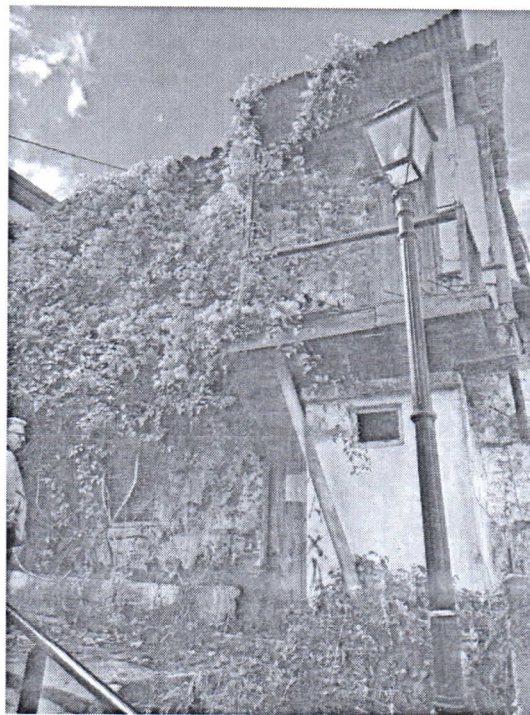
Φωτ 3 Όψη Γ
