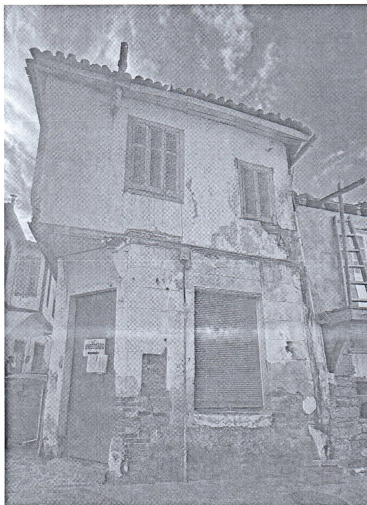
Φωτ 5 Όψη Γ
