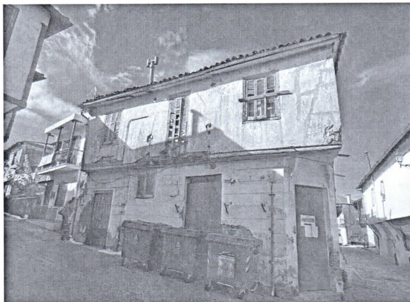
Φωτ 4 Όψη Β
