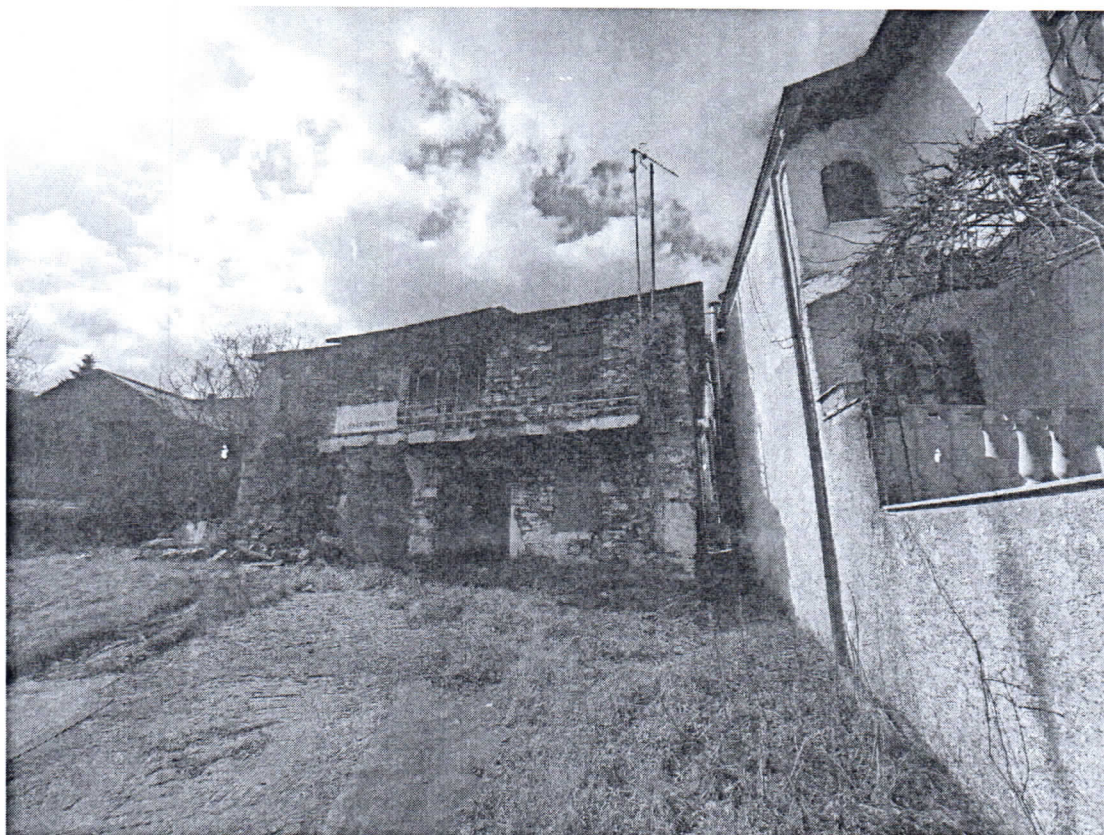
Φωτ. 2 Η πρόσοψη (όψη Α) του κτίσματος.
