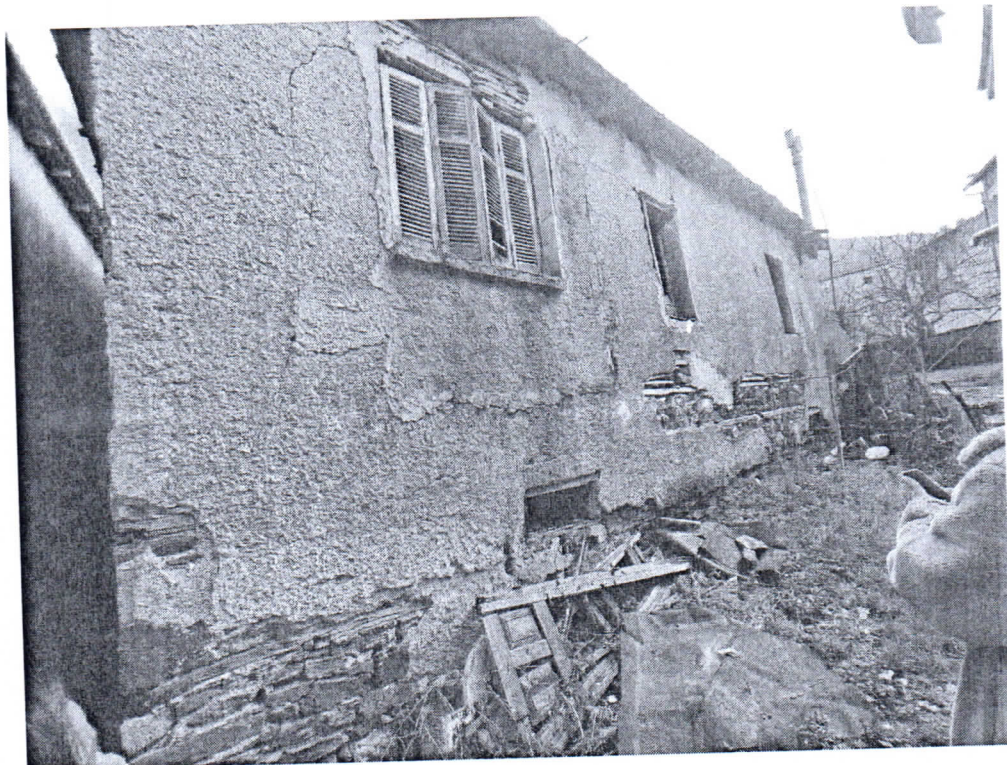
Φωτ. 5 Η πίσω όψη (Όψη Γ).
